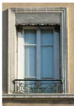
Menuiserie de type rénovation, la présence d'un double dormant réduit l'apport de lumière
