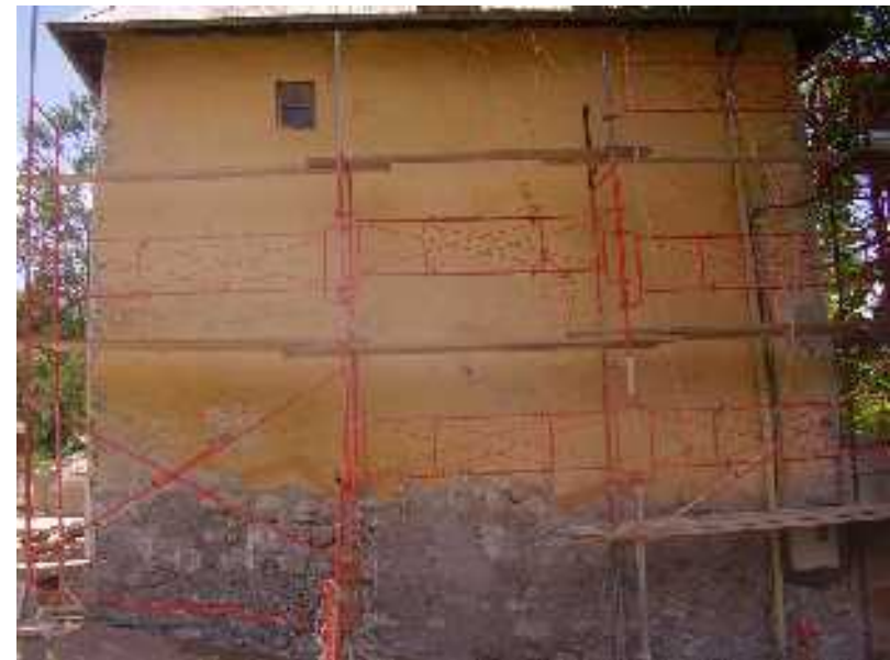
Batiment construit dans une pente et ayant tendance à « partir en avant »
