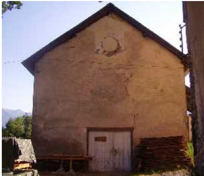
Tassement différentiel ou manque de résistance du linteau, création d'un arc de décharge.
