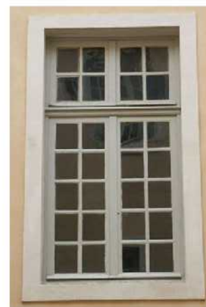
Fenêtre XVIIe avec sa menuiserie d'origine (maison des chartreux)
