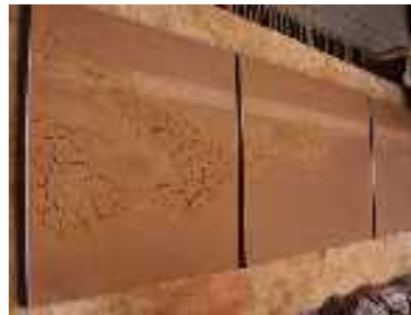
Fissure de surface localisé réalisé volomptairement par différence d'épaisseur de l'enduit
