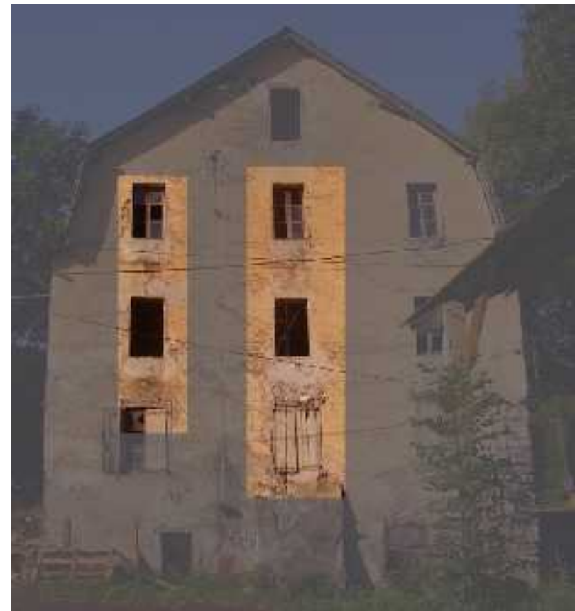
Fissure structurel : Les linteaux ou les sommiers ne supportes pas la surcharge.
